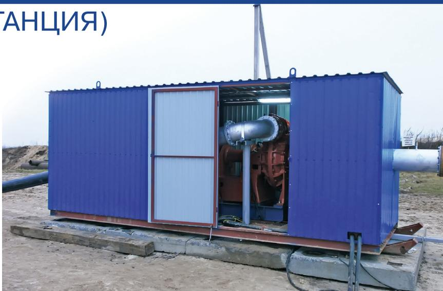
Бустерная станция состоит из электрического земснаряда ADST, производства компании «ЭПОС», на базе погружного грунтового насоса и перекачивающей станции с консольным землесосом.
